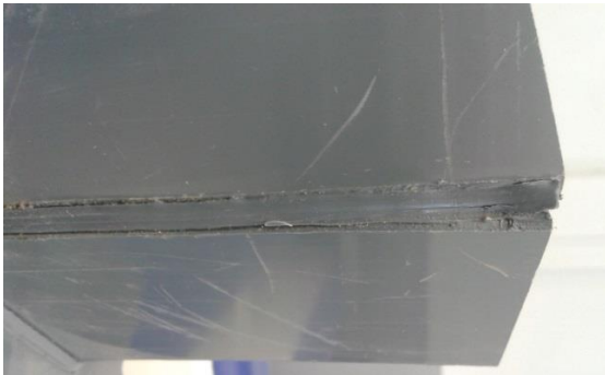
Brak właściwego wyrównania, nieprawidłowy dobór grubości drutu spawalniczego
